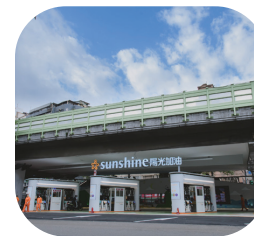
▲ 陽光建北加油站外觀照
