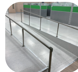
▲為身心障礙同仁工作場域客製輪椅坡道及扶手設施
